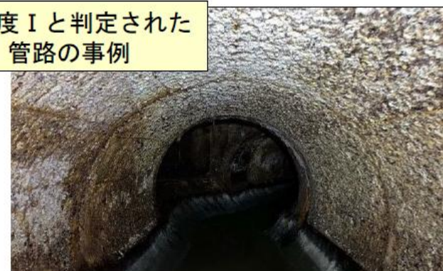
管の腐食から緊急度Ⅰと判定
