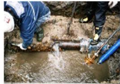
埋設後60年経過した鋳鉄管の漏水
