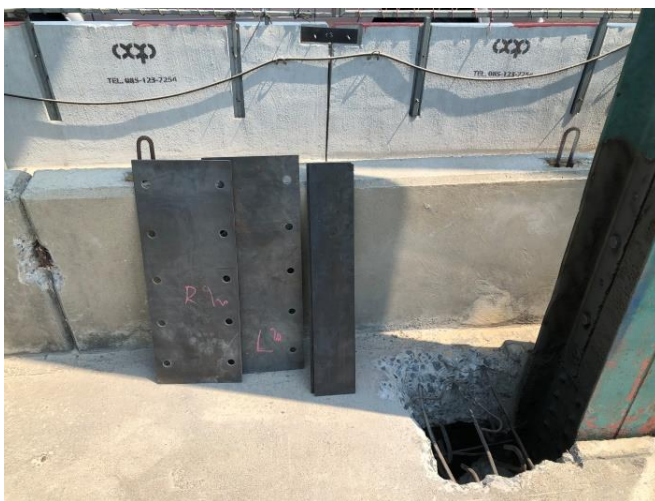
写真－11 鉛直材補強用の当て板
