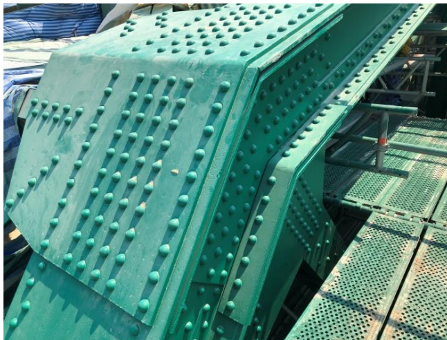
写真－4 トラス部斜材と上弦材の交点付近 (ほとんど腐食無し)
