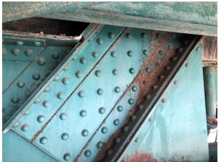
写真-6 トラス橋のリベット構造 (トラス下弦材より下、支承付近)
