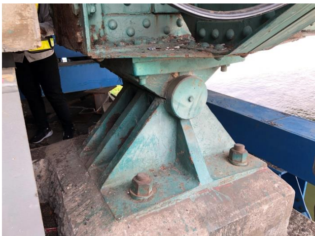
写真－13 トラス部の鋼製ピンタイプ(固定)支承
