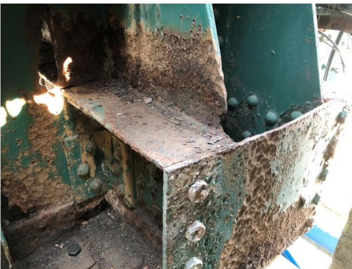
写真-7 トラス桁の桁端部
