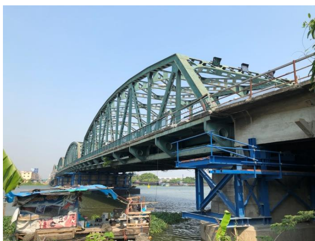
写真－2 ノンタブリ橋の全景(桁下から)
