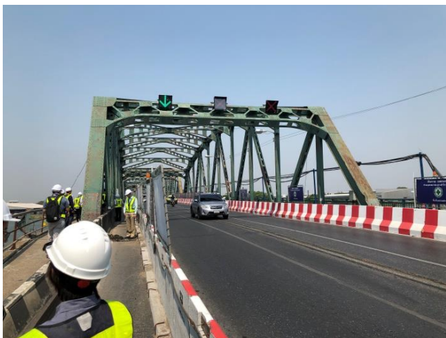
写真－3 トラス桁部分の橋面
