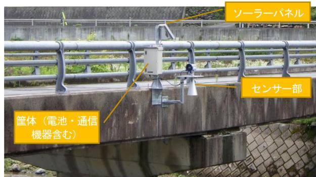
写真-2 危機管理型水位計(非接触型)の例<sup>2)</sup>
