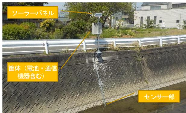
写真-1 危機管理型水位計(接触型)の例<sup>2)</sup>
