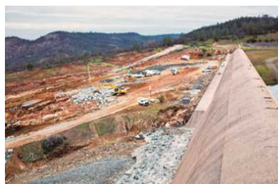
非常用洪水吐越流部の状況 (カリフォルニア州水資源局)
