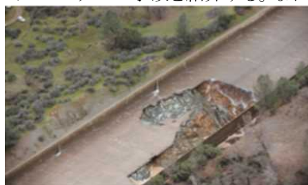
常用洪水吐シュート部の洗堀 (カリフォルニア州水資源局)
