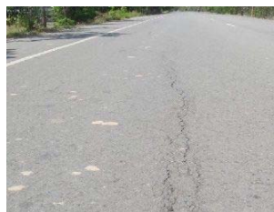
ひび割れ (カンボジア)
